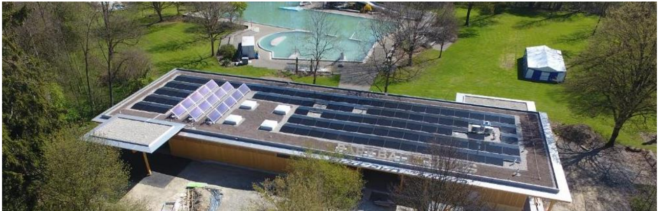
Sicht von oben/Eingangsseite - mit der Photovoltaikanlage (ca. 100kWp) und der Solarthermie
