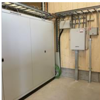
Links zwei grosse Speicher für das Warmwasser via Solarthermie, Mitte Elektroschrank, Rechts die Wechselrichter für die Einspeisung aus der Photovoltaikanlage
